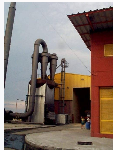
Parte externa do sistema de captação de poeira, composto por ciclones e exaustores
