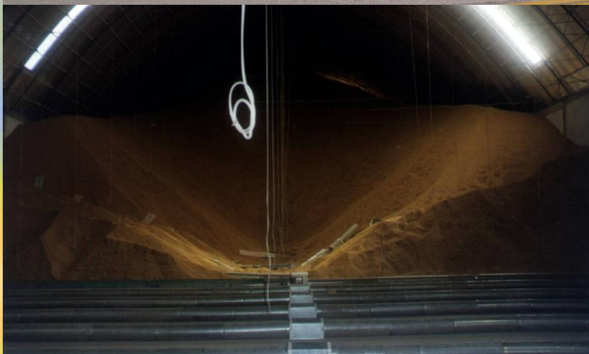
Armazém graneleiro, de alvenaria, dotado de cabos de termometria e canaletas de aeração sobre o piso plano, de concreto
