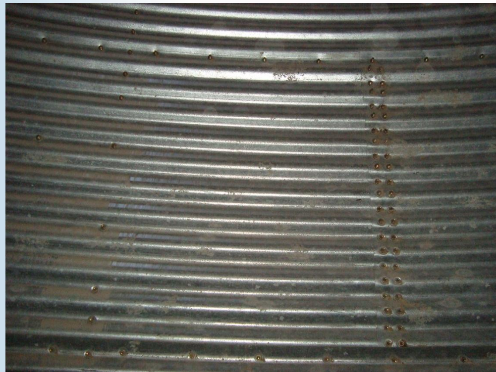
Limpeza em parede de silo metálico em armazenamento de arroz Fonte: Schiavon, Oliveira e Elias, 2013
