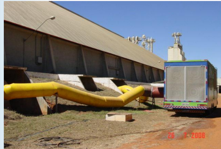
Armazém graneleiro, de alvenaria, dotado de sistema de resfriamento para conservação de grãos
