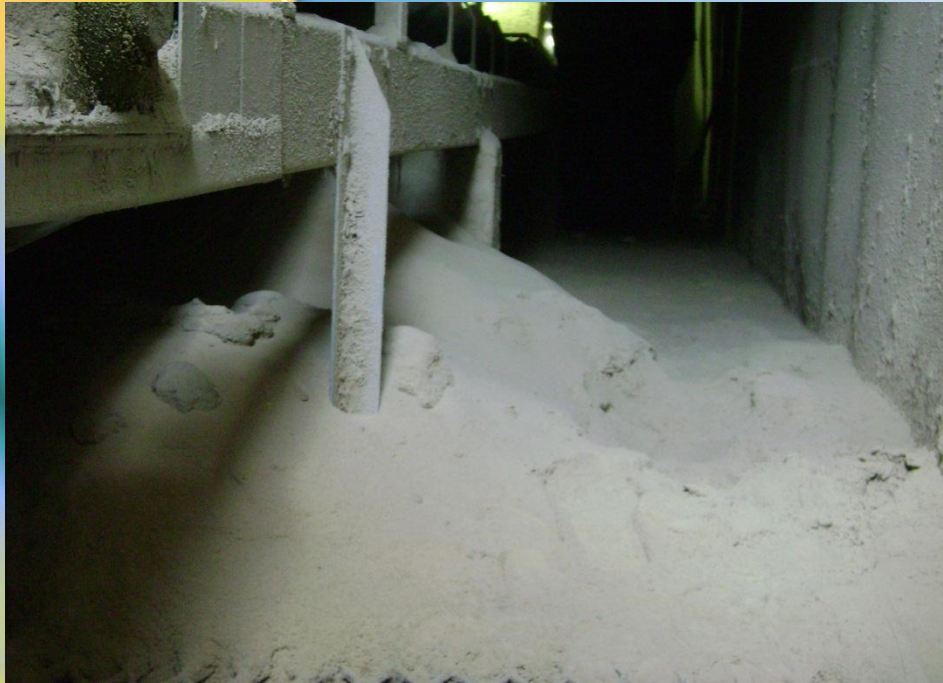
Falta de limpeza de túneis de descargas de grãos nas unidades armazenadoras de grãos. Fonte: Dionello, 2008
