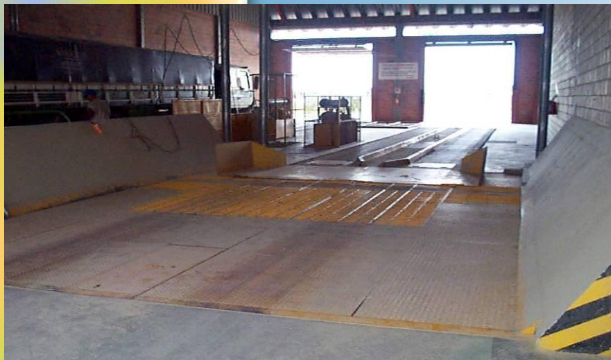
Recepção de grãos, com moega, plataforma basculante e balança.
