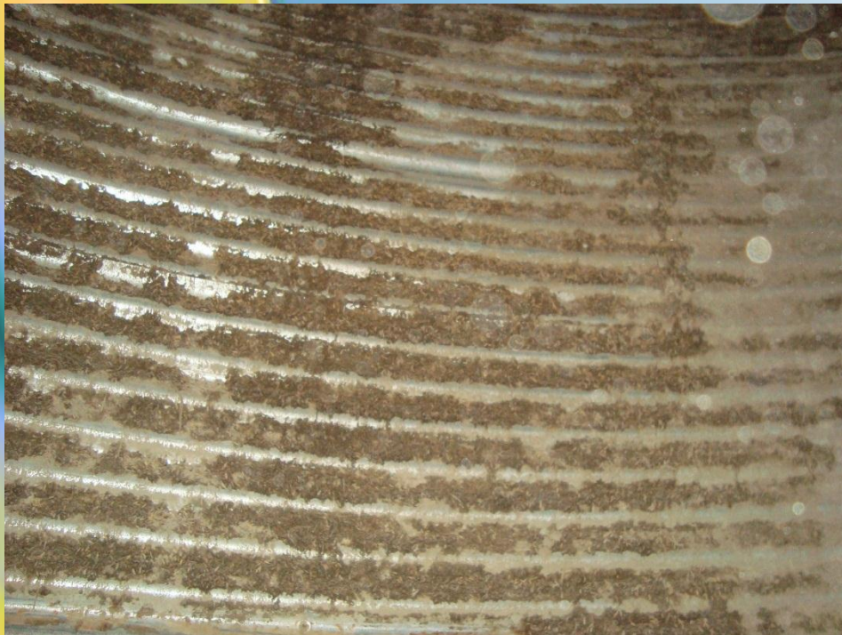
Falta de limpeza em parede de silo metálico em armazenamento de arroz Fonte: Schiavon, Oliveira e Elias, 2013
