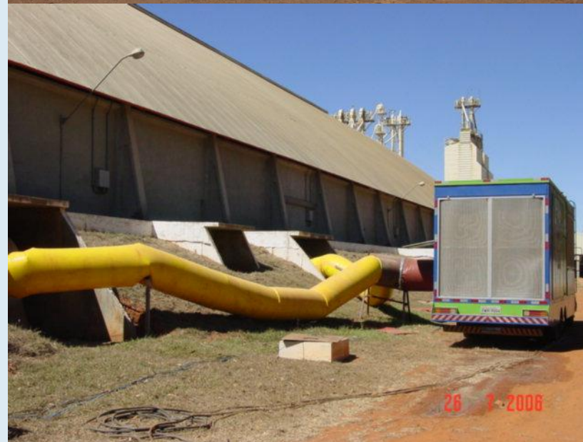
Armazém graneleiro, de alvenaria, dotado de sistema de resfriamento para conservação de grãos
