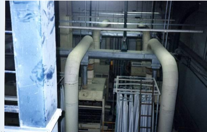
Sistema interno de captação de poeira acoplado à operação de limpeza de grãos
