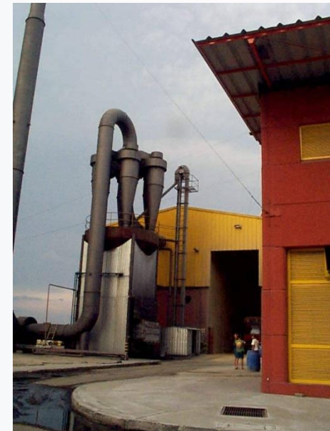
Parte externa do sistema de captação de poeira, composto por ciclones e exaustores
