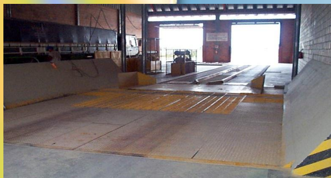
Recepção de grãos, com moega, plataforma basculante e balança.
